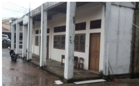
Gambar 3. Eksisting Bagian Luar Ruangan Kelas pada MDA Masjid Yasin Almunatsir
