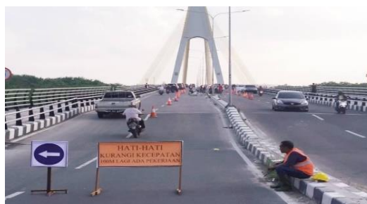
Gambar 2. Oprit Jembatan Siak IV
