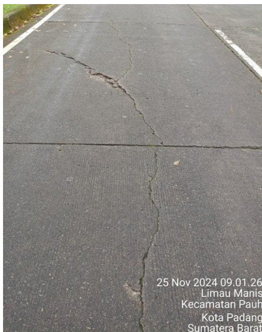
Gambar 1. Retak longitudinal
