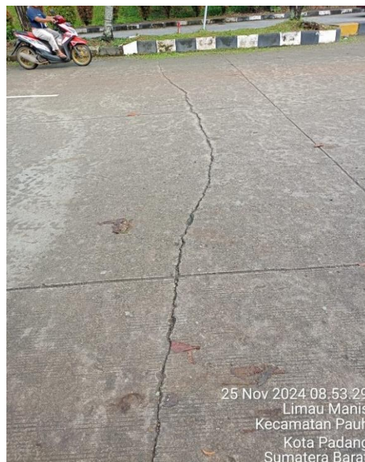
Gambar 2. Retak transversal
