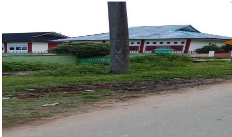
Gambar 2. Lokasi Jalan di Desa Siabu yang memiliki drainase
