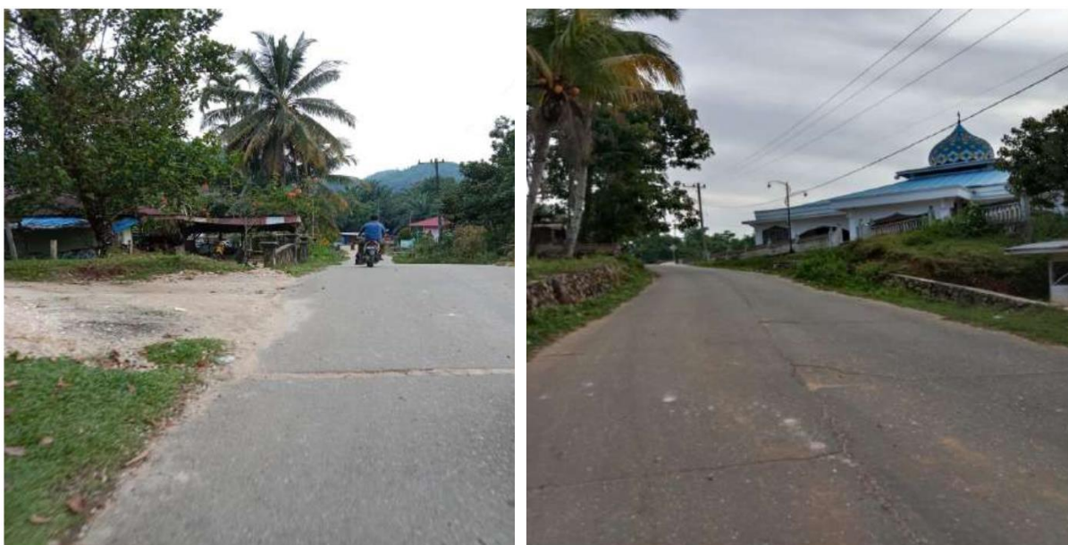
Gambar 1. Lokasi Jalan di Desa Siabu yang tidak memiliki drainase
