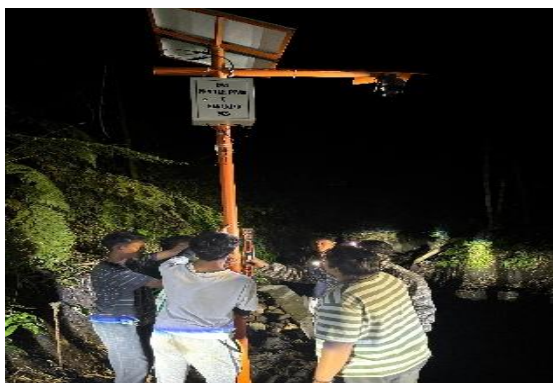
Gambar 3. Pemasangan Alat EWS
