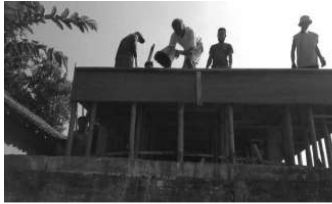
Gambar 7. Pengecoran Plat Lantai atas
