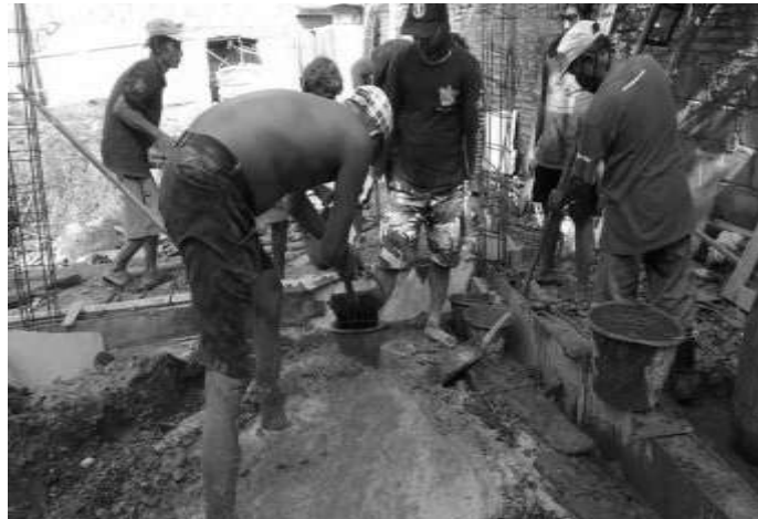
Gambar 4. Pengecoran Sloof
