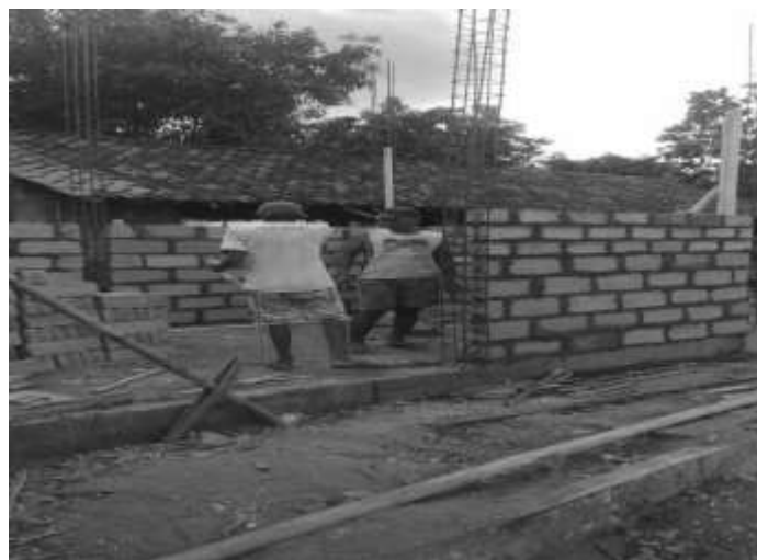
Gambar 5. Pemasangan Batako
