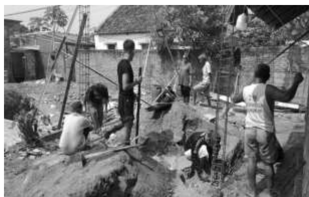
Gambar 3. Pemasangan Tulangan Sloof dan Tulangan Kolom
