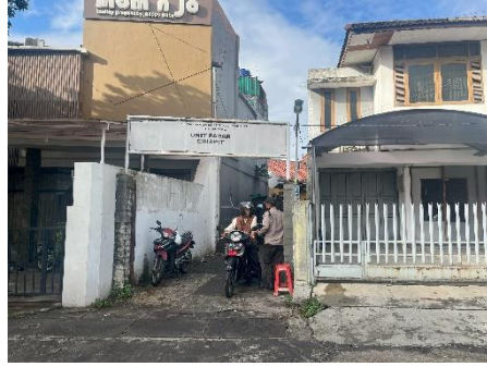
a) Kondisi pada Akses C
