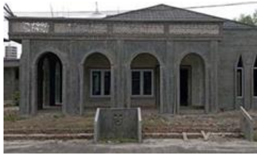
Gambar 1 Kondisi bangunan Baru Mushalla Al-Amin
