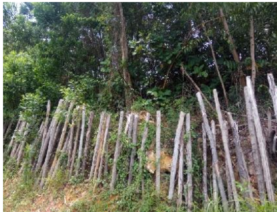
Gambar 3. Kondisi alami lereng setelah longsor dan diberi perkuatan cerocok kayu
