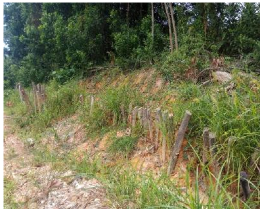
Gambar 3. Kondisi alami lereng setelah longsor dan diberi perkuatan cerocok kayu
