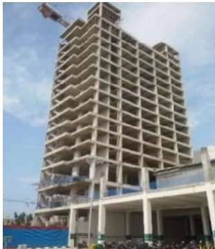
Gambar 7. Gedung objek penelitian
