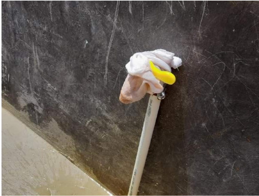
Gambar 8. Kain Penyaring yang berwarna kuning kemerahan sebagai filter untuk air sumur yang digunakan
