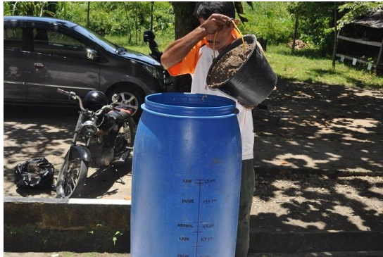
Gambar 12. Masukkan bahan-bahan penjernih air sesuai ketebalan yang telah ditentukan
