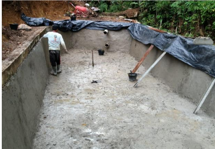
Gambar 4. Pembuatan Bak Penampung Utama
