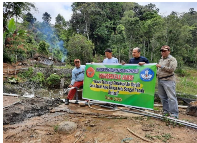
Gambar 7. Uji Coba Air Dari Bak Penampung
