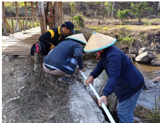
Gambar 5. Pemasangan Pipa Dari Bak Utama ke Area Perkebunan
