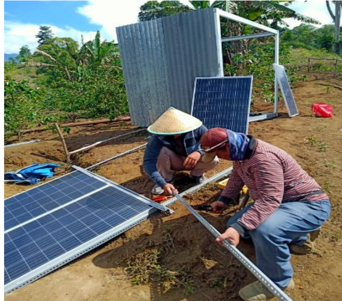
Gambar 6. Pemasangan Panel Surya
