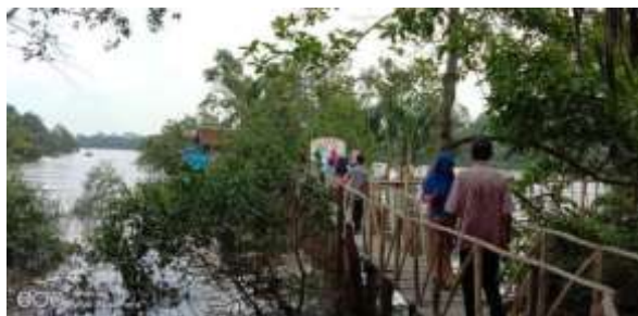
Gambar 9. Jembatan kayu yang sudah dibangun
