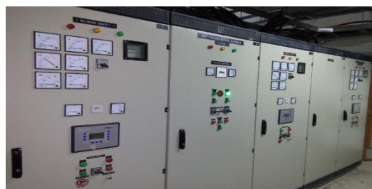
Gambar 5. Panel LVMDP pada gedung Central Operation Theatre RS Arifin Achmad
