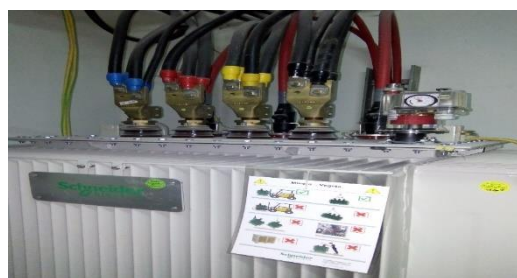
Gambar 2. Transformator Daya pada Gedung COT RS Arifin Achmad
