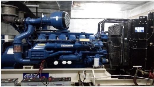
Gambar 3. Diesel Generator pada RS Arifin Achmad
