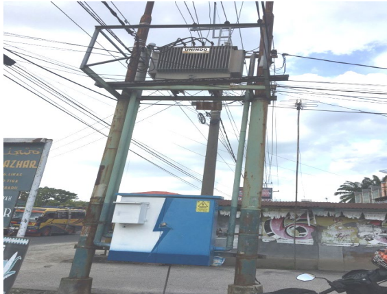
Gambar 2. Konstruksi Gardu Distribusi ST 263
