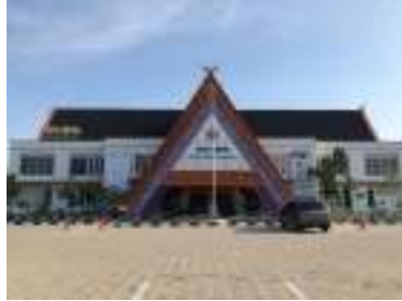
Gambar 4: Tampak depan gedung kantor BPN –ATR yang menghadap ke jalan utama
