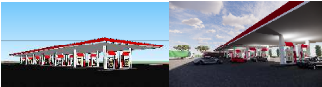
Gambar 18. SPBU (Sumber : Dokumentasi Pribadi, 2022)
