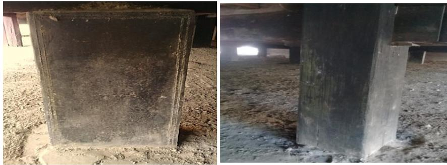
Gambar 2. Bentuk pondasi sebagai struktur bawah bangunan masjid Jamik
