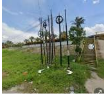
Gambar 12. Tiang Listri Pada Tapak (Sumber : Dokumentasi pribadi, 2025)
