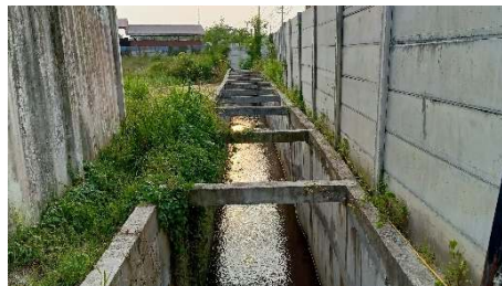
Gambar 24. Riol Air Kotor (sumber : dokumentasi pribadi)
