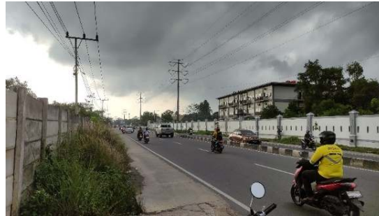
Gambar 23 Tiang Listrik di sekitar Tapak (sumber : dokumentasi pribadi)
