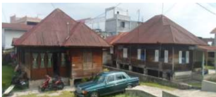
Gambar 8. Bentuk estetika bangunan Sumber: hasil survey
