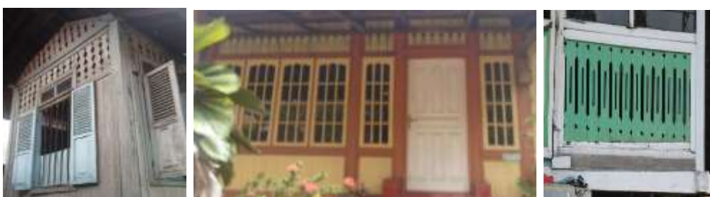
Gambar 7. Bentuk estetika bangunan Sumber: hasil survey
