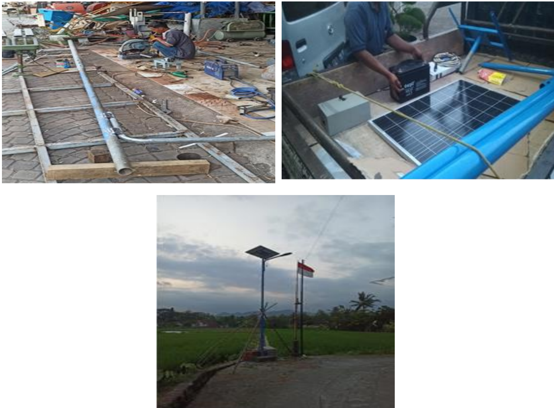
Gambar 8. Perakitan dan Pemasangan
