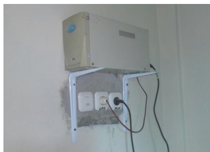
Gambar 12. Dudukan dan Pemasangan UPS
