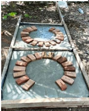
(a) Pengalasan sebelum pengecoran
