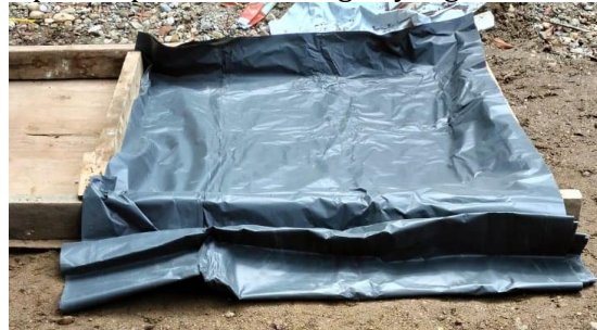
(a) Pengalasan sebelum pengecoran
