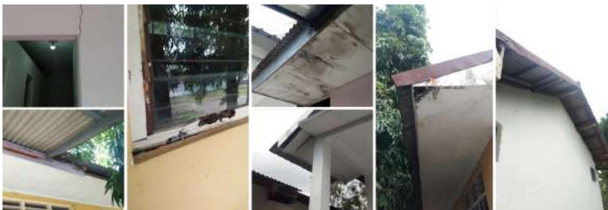
Gambar 2 Kondisi Ketidaklayakan Bangunan Sekolah YPAB, (Dari Kiri) Keretakan Dinding Sambung, Kayu Jendela dan Kayu Atap yang Termakan Rayap, serta Atap Plafon Yang Lapuk Dan Terlepas
