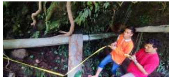
Gambar 3. Proses Pengukuran Panjang Pipa Air Bersih
