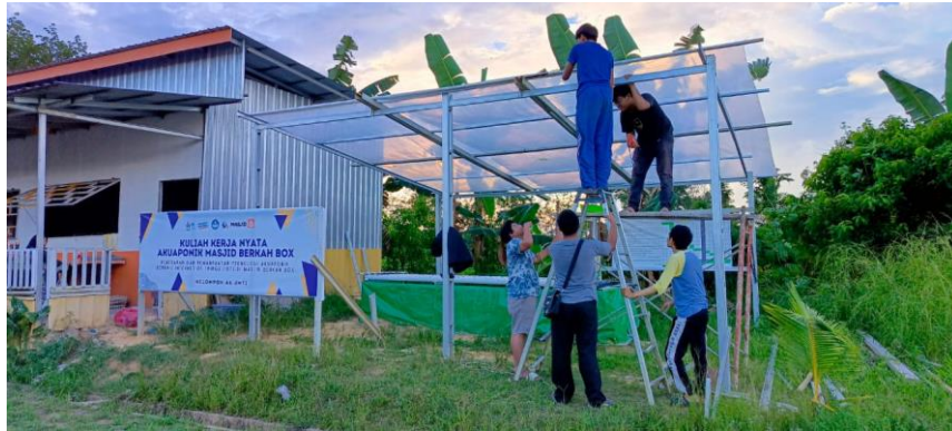
Gambar 3. Pemasangan atap UV dan perisapan instalasi sensor DHT 11 untuk kolam Akuaponik
