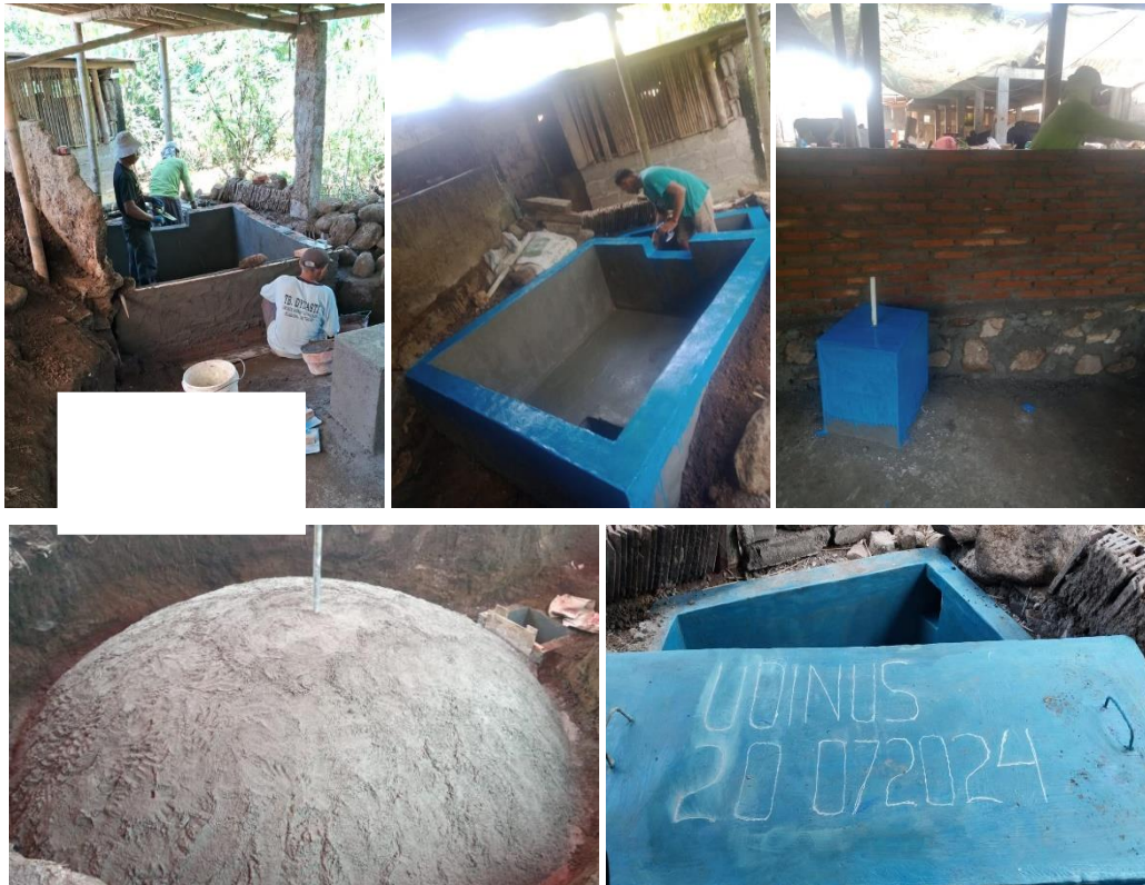
Gambar 2. Pembangunan instalasi biodigester di Desa Banyuanyar Kabupaten Boyolali
