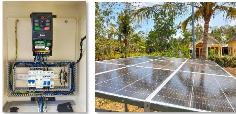
Gambar 10. Pengujian system PLTS di lokasi
