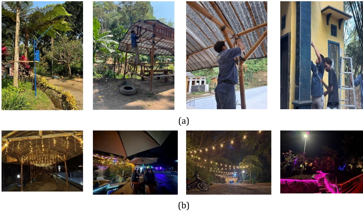
Gambar 3 (a) Proses pemasangan lampu; (b) beberapa lampu yang telah terintegrasi kelistrikan dari energi terbarukan
