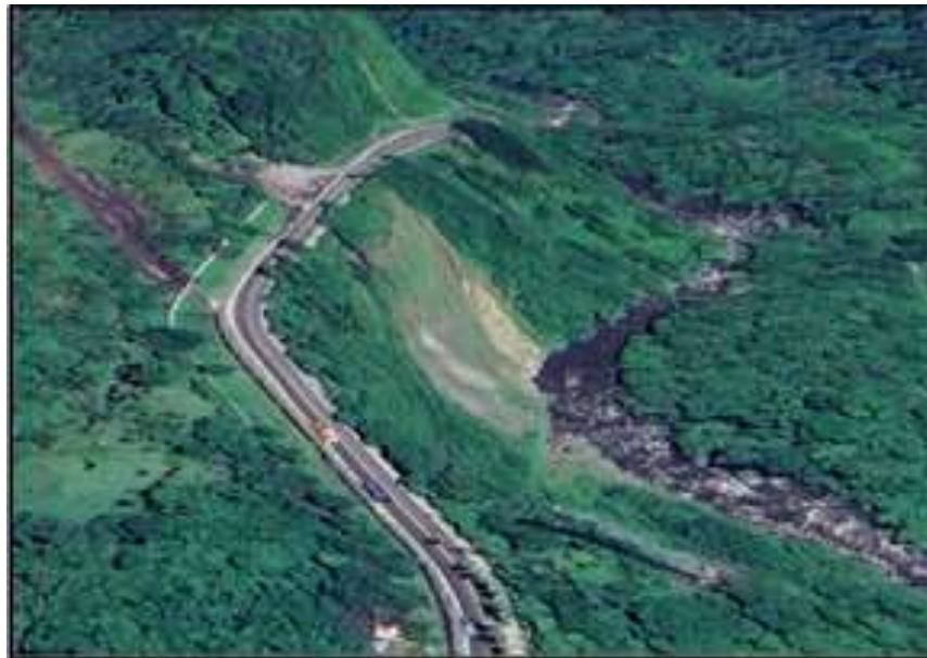
Gambar 2. Kondisi tebing sebelum longsor (Sumber : google earth, 23 Februari 2024)
