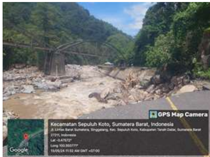
Gambar 1. Jalan nasional yang menghubungkan Kota Padang dan Bukittinggi putus akibat banjir bandang
