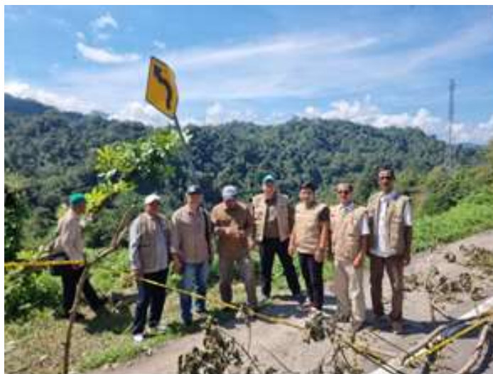
Gambar 4. Kegiatan survei lokasi kerusakan
