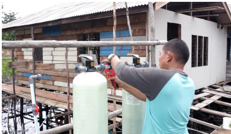
Gambar 3. Dokumentasi proses pembangunan instalasi filter air bersih
