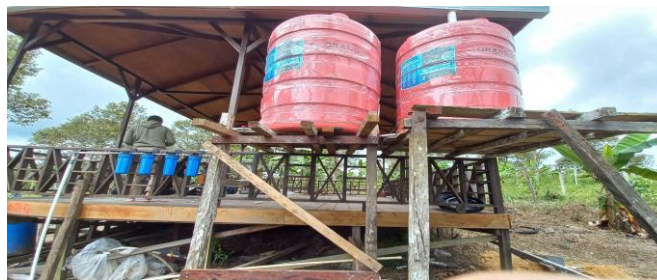
Gambar 7. Talang pengumpul air hujan, tangki penampungan, dan filter yang dipasang sebagai rangkaian sistem RWH untuk KTHS
