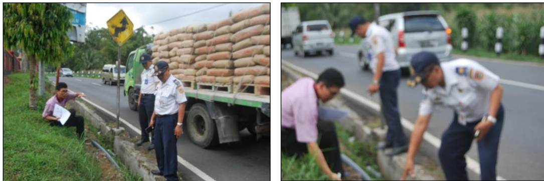
Gambar 3. Penentuan lokasi pemasangan rambu batas kecepatan maksimum di ruas jalan Tlahab
