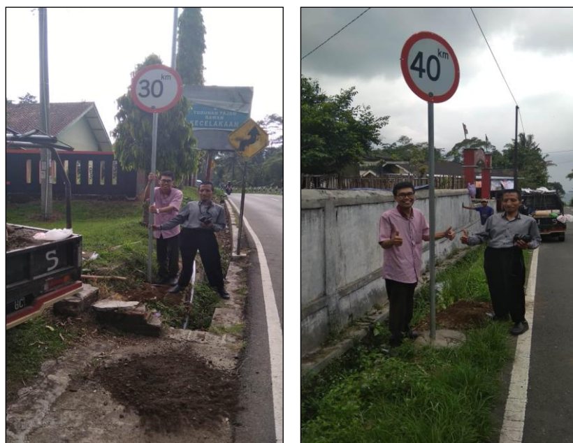
Gambar 4. Pemasangan rambu batas kecepatan maksimum 30 dan 40 km/jam di ruas jalan turut Desa Tlahab, Karangreja, Purbalingga
