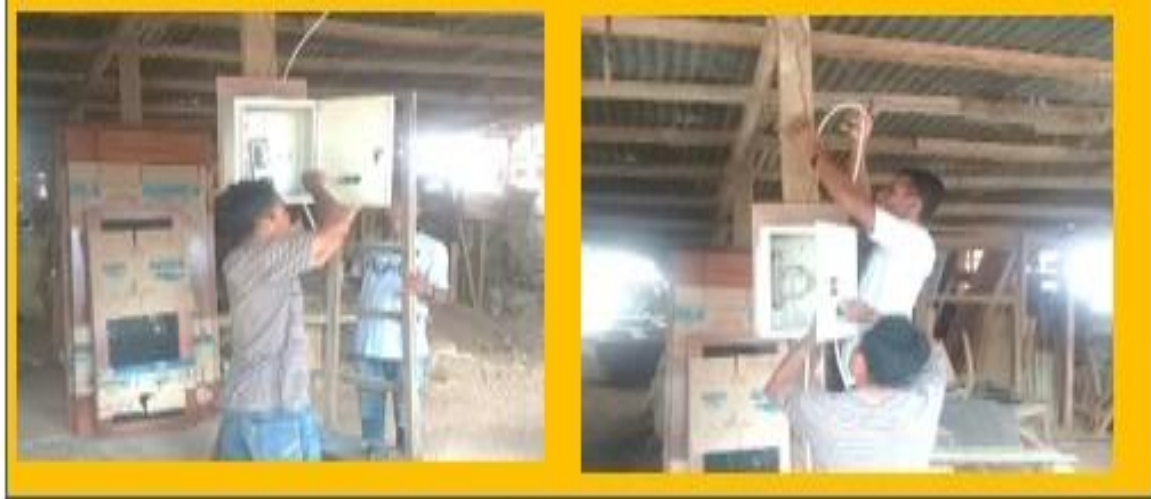
Gambar 13. Proses Pemasangan Instalasi Listrik Pada Workshop Mitra
