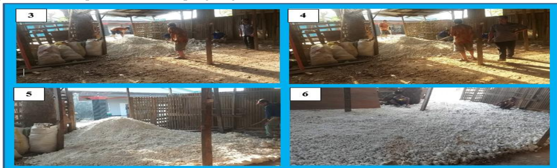
Gambar 7. Pengurugan tanah timbunan pada ruang workshop UMKM Mitra
