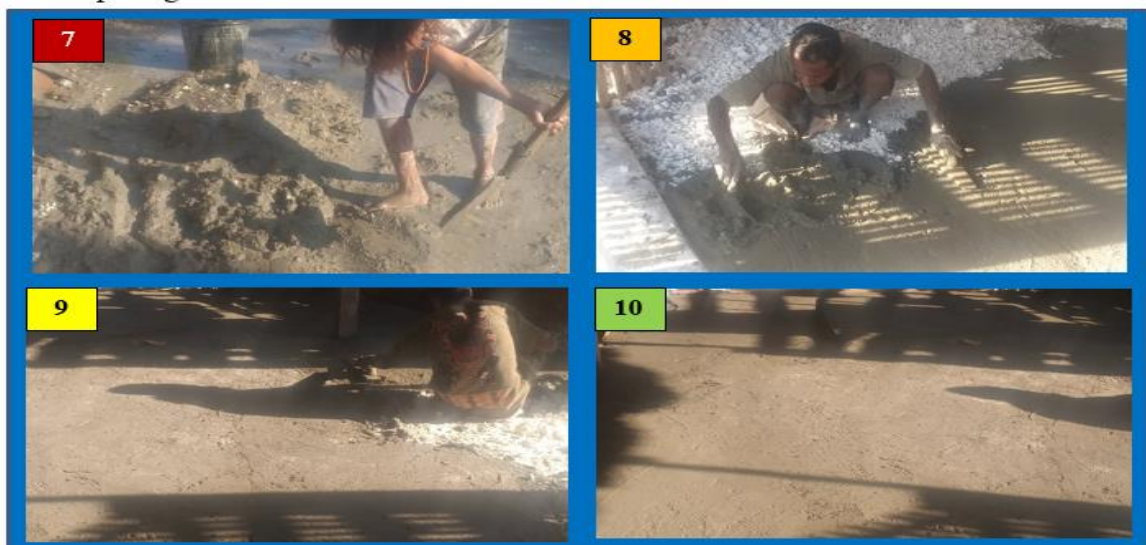
Gambar 9. Pengerjaan Plesteran Semen Lantai pada ruang workshop UMKM Mitra
