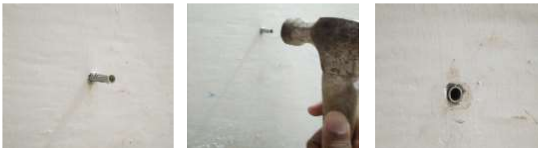
Gambar 10. Proses pemasangan fischer
