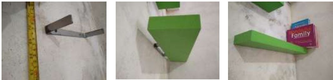
Gambar 14. Pemasangan rak
