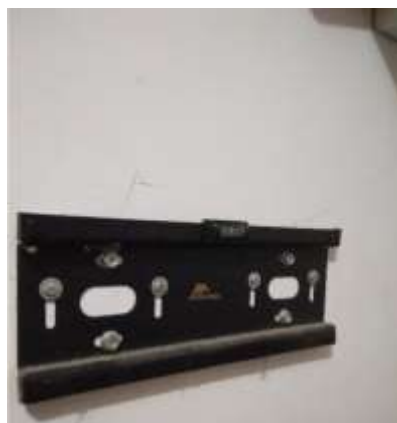
Gambar 16. Pemasangan briket TV
