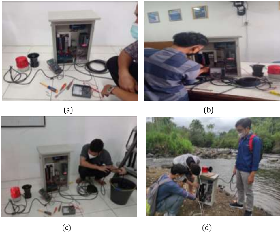
Gambar 6. Pengujian (a) PLTS. (b) Seluruh komponen. (c) Setting level. (d) Pengoperasian alat disungai.
