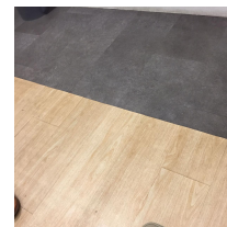
Gambar 10. Lantai Sesudah Renovasi menggunakan keramik motif kayu dan beton
