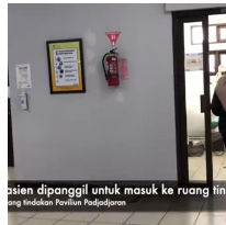
Gambar 5. Dinding Ruang Sebelum Renovasi
