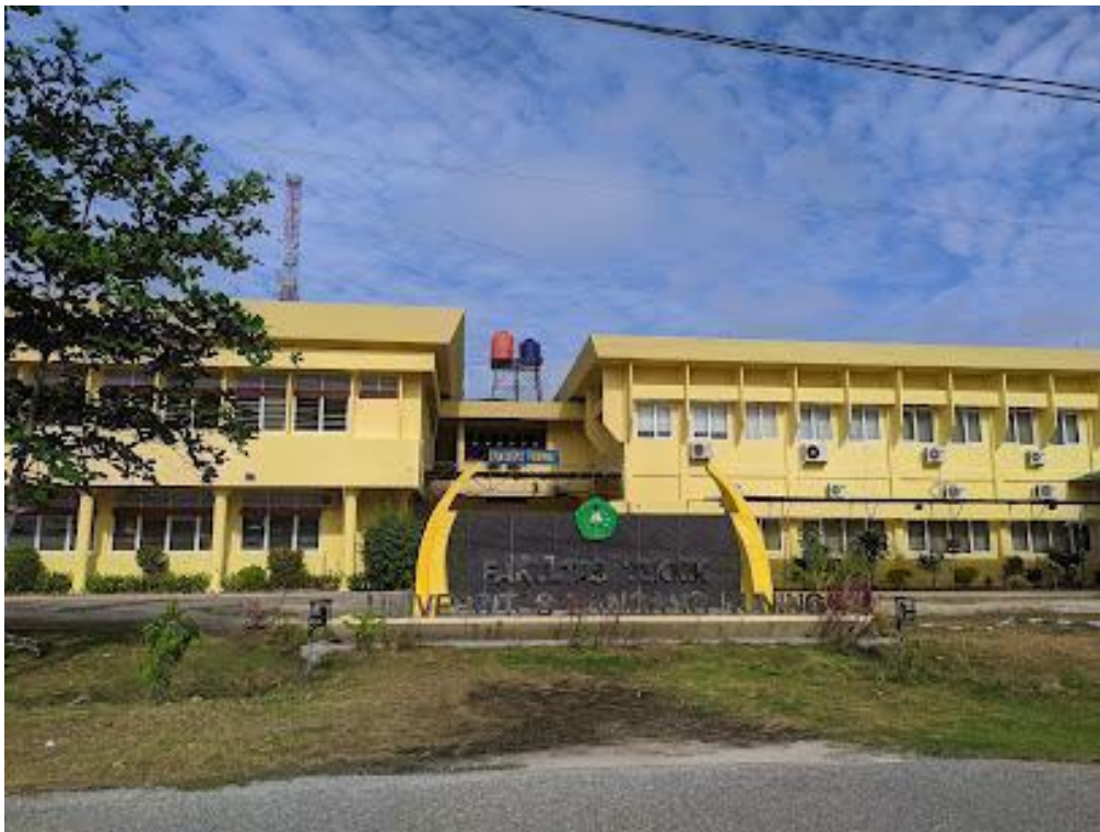
Gambar 1. Bangunan Fakultas Teknik Unilak Sumber : Penulis, 2023
