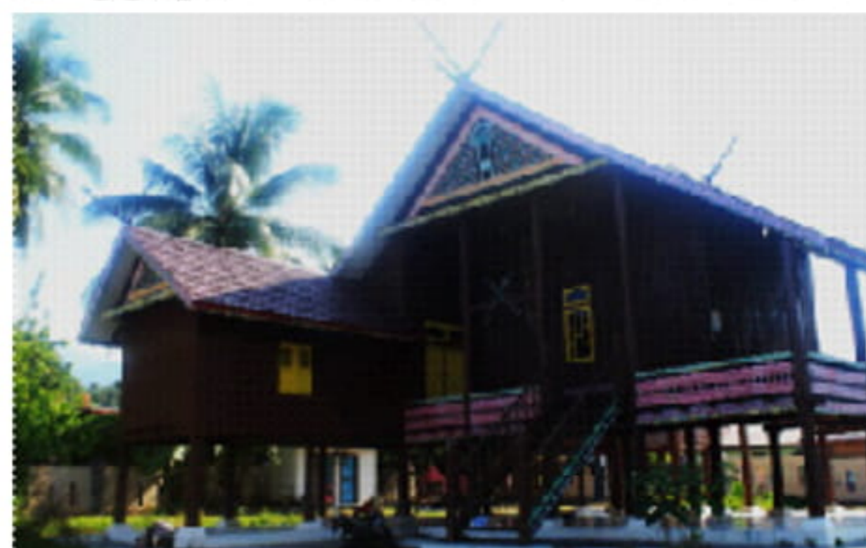
Gambar 1 Rumah Adat Alas Aceh Tenggara (Foto: Saniman Andi Kafri)
