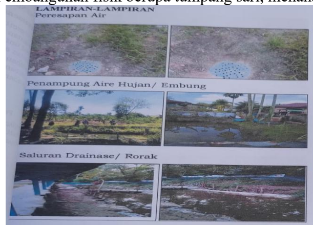
Gambar 3. Pembangunan fisik berupa peresapan air, penampung air hujan/embung, saluran drainase/lorak Menurut Dinas Lingkungan Hidup dan Kebersihan pada komitmen terhadap proses:
