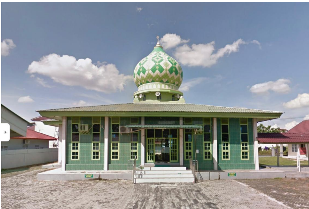
Gambar 2. Kondisi Eksisting Masjid Jabal Rahmah Pekanbaru
