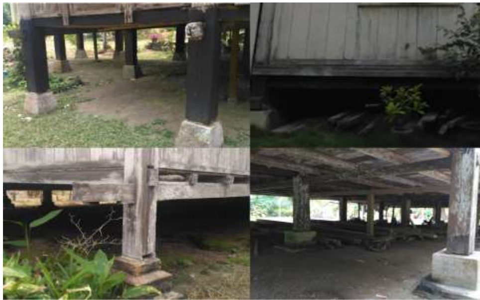
Gambar 2: Kondisi Penghawaan Pada Bagian Bawah Bangunan
