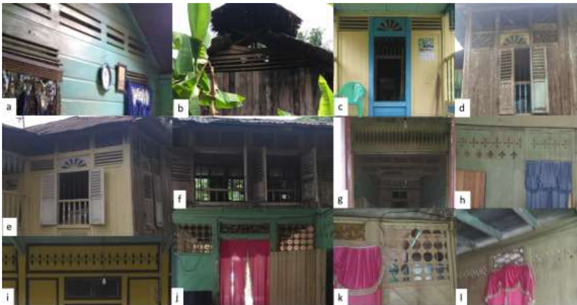
Gambar 3: Bukaan pada bangunan (a) dinding ruang kamar dan ruang tengah, (b) dinding dapur berupa kisi-kisi pada bagian atas, (c) pintu depan dan ventilasi pintu, (d) jendela dan ventilasi jendela serta dinding bagian atas, (e) dinding dibawah atap, (f) jendela dan kisi-kisi sirap, (g) lobang dinding antara ruang depan dan ruang tengah, (h) dinding kamar dan ruang depan, (i) bentuk lain lobang dinding pada pintu depan, (j) bukaan dinding ruang tengah dan ruang depan, (k) bentuk lain bukaan dinding dalam, (l) bukaan antara plafon dan dinding dalam bangunan.
