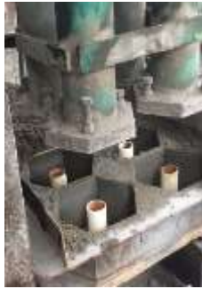
Gambar 2. Meletakkan Pipa dalam Cetakan
