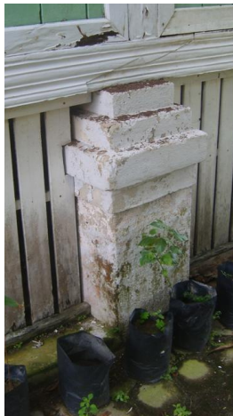
Gambar 3.4 : Bentuk Pondasi Pasangan Batu Bata
