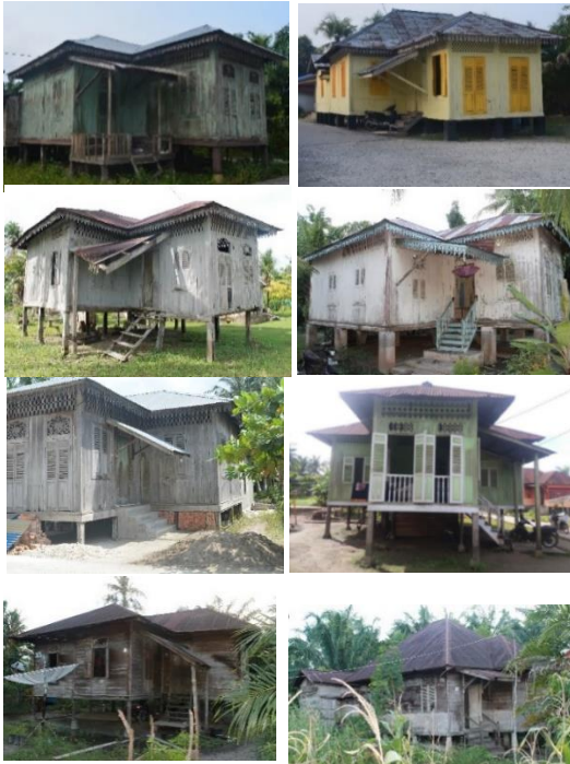
Gambar 1. Bangunan atap limas perabung belah Sumber : survey lapangan
