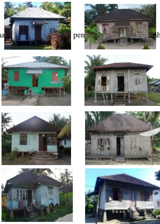
Gambar 3. Bentuk atap limas perabung belah dengan denah persegi panjang Sumber: survey lapangan
