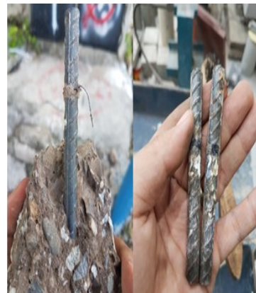
Gambar 4. Sampel Uji Korositas
