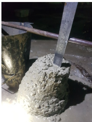
Gambar 5. Pengukuran Nilai Slump
