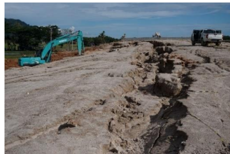
Gambar 2. Dokumentasi Keruntuhan Lereng STA 4+400 – 4+600
